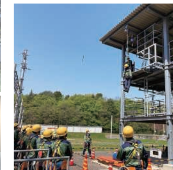
高所作業実習設備
