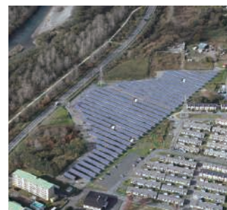
日本電設白老町川沿ソーラーファーム 設置面積:約25,700㎡ 発電規模:約1,250kW
