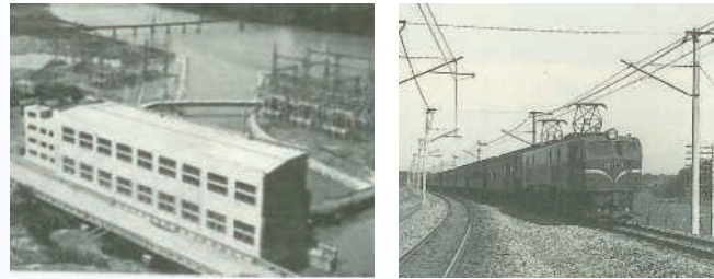
国鉄小千谷発電所 国鉄大宮～宇都宮間電化
