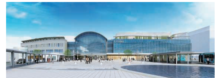
JR四国高松駅ビル「TAKAMATSU ORNE(オルネ)」
