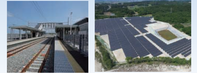
常磐線 新地駅(震災復旧) 大崎三本木太陽光発電所
