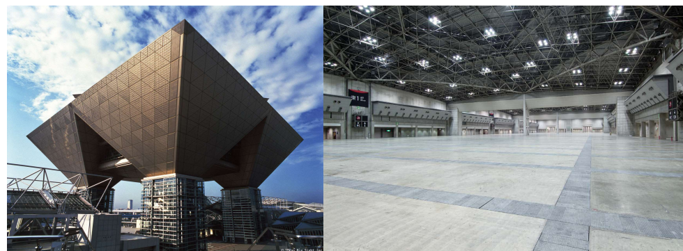
東京国際展示場（6）東展示棟改修電気設備工事
