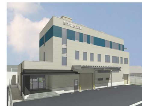
NDK長野ビル（建設中）
