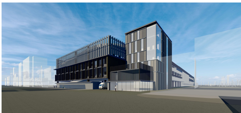
京都市中央卸売市場第一市場整備工事 ただし、新青果棟（仮称）電気設備工事
