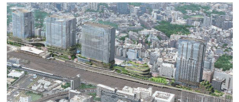
TAKANAWA GATEWAY CITY 地域エネルギー供給電気設備工事
