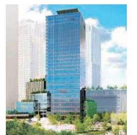
北街区賃貸棟
