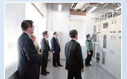
屋内実習設備の視察
