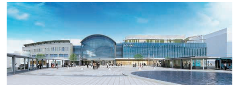
JR四国高松駅ビル「TAKAMATSU ORNE(オルネ)」
